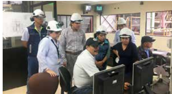
Sala de control Caldera N°. 9.
