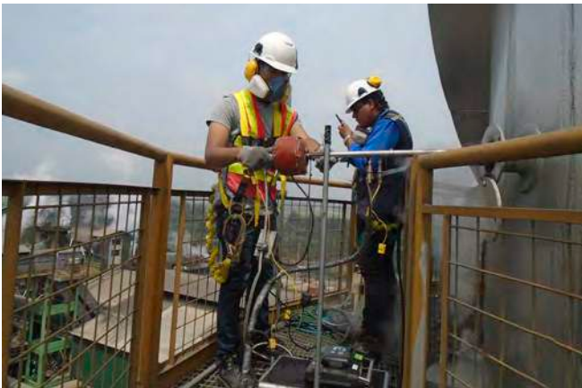
Uso de EPP en trabajos en altura
